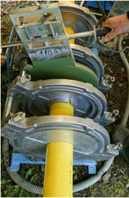
Bild 3. Schon bei der Entwicklung des Kunststoffstoffs muss die spätere Verbindungstechnik auf der Baustelle mitbedacht werden
