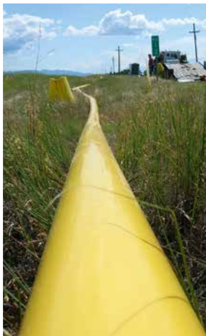
Bild 2. In den vergangenen Jahren sind zahlreiche Testinstallationen sowie eine Reihe von kommerziellen Installationen mit PA12-Rohren erfolgt
