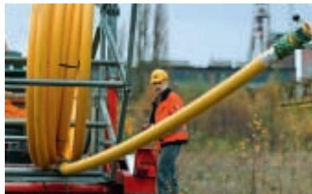
Bisher bestanden Gasleitungen aus Stahl, jetzt können flexible, aber nicht weniger stabile Rohre aus VESTAMID verlegt werden
