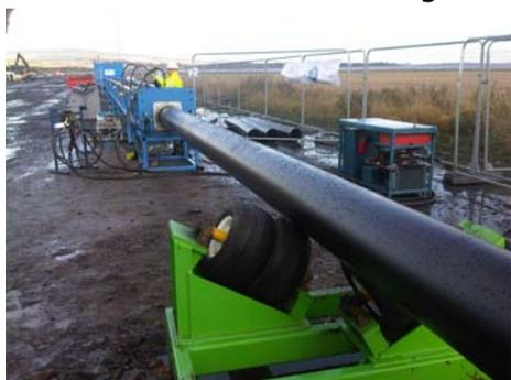
**Bildunterschrift:** Installation eines Kunststoff-Liners mittels Swagelining™-Technologie.
